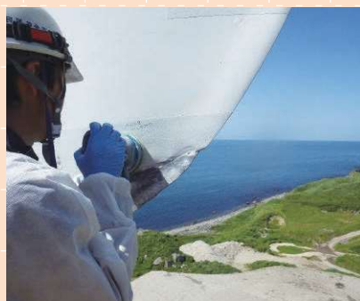
ブレード補修
